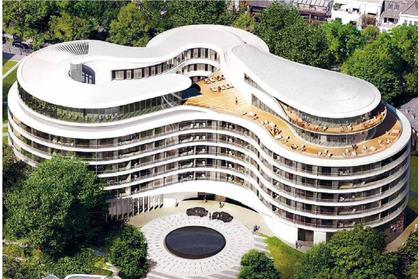
Hotel Fontanay, Luogo: Amburgo - Germania, Prodotto: Collezione speciale Contract, Architetto: Störmer Murphy and Partners, Anno: 2017
