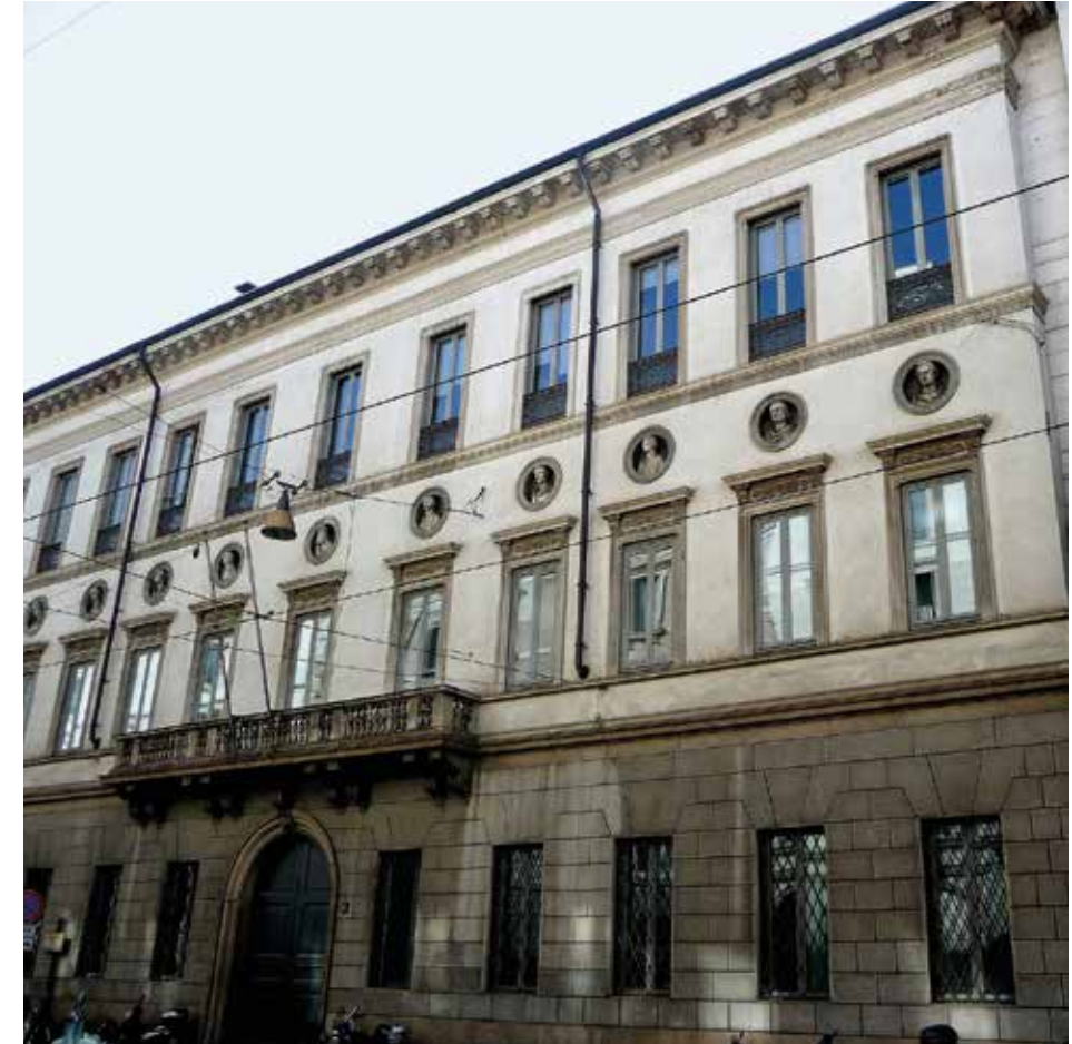
Gallerie d'Italia - Piazza Scala, Luogo: Milano - Italia, Prodotto: Atelier Réserve Siena 1348, Progetto: aMDL Architetto Michele De Lucchi, Anno: 2015 Gallerie d'Italia - Piazza Scala, Place: Milan - Italy, Products: Atelier Réserve Siena 1348, Project: aMDL Architect: Michele De Lucchi, Year: 2015 Photo: Mario Carrieri
