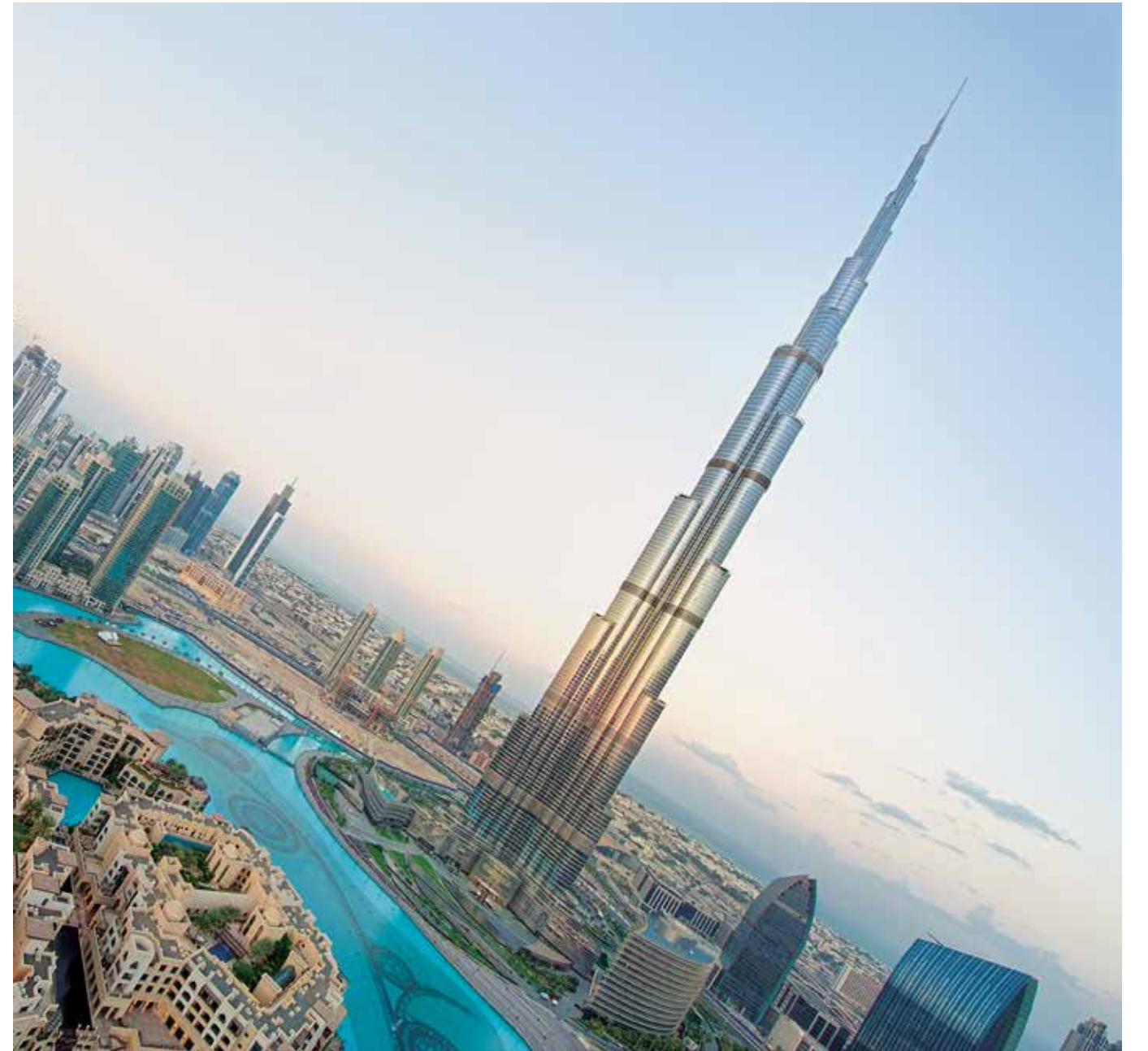
Burj Khalifa Dubai, Luogo: Dubai - UAE, Prodotto: realizzazione speciale in Doussié, Architetti: SOM/Skimore Owing and Merrill, Anno: 2008
